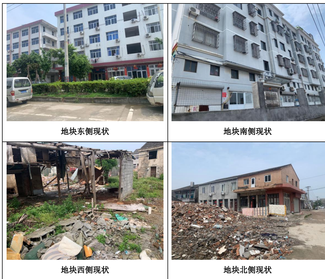
图 2-12 地块现状照片
